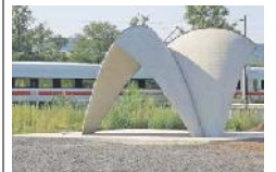
Demonstrator aus Textilbeton-Fertigteilen. Foto: Texton
